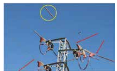
Εικόνα 11: Παραδείγματα καλυμμάτων τα οποία δεν τοποθετήθηκαν σωστά οδηγώντας σε μερική ή πλήρη έκθεση φορτισμένων μερών. α) Εκτεθειμένο μεταλλικό μέρος τερματισμών αγωγών ©Justo Martín. β) Κακή τοποθέτηση του καλύμματος (χιτώνιο) στον εναέριο αγωγό που οδήγησε σε αποκόλλησή ©Justo Martín. γ) Κακή τοποθέτηση του καλύμματος (χιτώνιο) στον εναέριο αγωγό που οδήγησε σε αποκόλληση και μετακίνησή του κατά μήκος του αγωγού ©James Dwyer (πηγή: Martín Martín et al., 2022).
