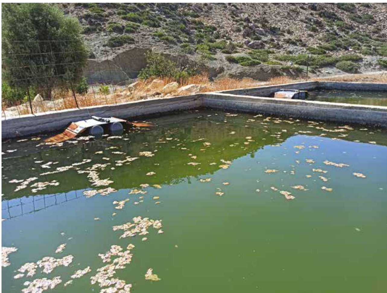
Εικόνα 11: Πρότυπο διάταξης διαφυγής σε τσιμεντένιες δεξαμενές κάθετων τοιχωμάτων, στο πλαίσιο του έργου LIFE Bonelli eastMed. ©Αρχείο ΠΚ-ΜΦΙΚ.
