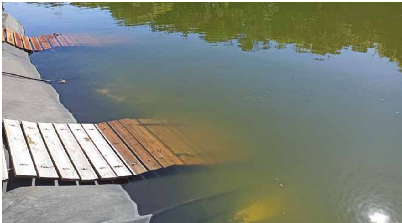
Εικόνα 10: Διάταξη αύξησης πρόσφυσης, σταθεροποιημένη σε δεξαμενή με κεκλιμένα τοιχώματα. LIFE Bonelli eastMed©Αρχείο ΠΚ-ΜΦΙΚ.
