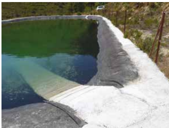
Εικόνα 7: Ράμπα από σκυρόδεμα. Πηγή: Cap del Servei de Biodiversitat i Protecció dels Animals.
