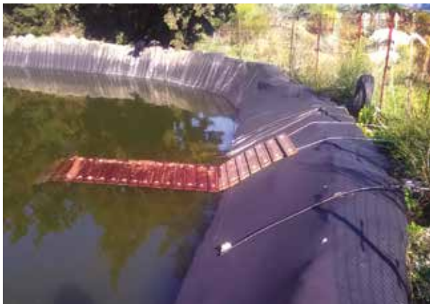
Εικόνα 14: Λανθασμένη τοποθέτηση σταθερής διάταξης διαφυγής. LIFE Bonelli eastMed©Αρχείο ΠΚ-ΜΦΙΚ.
