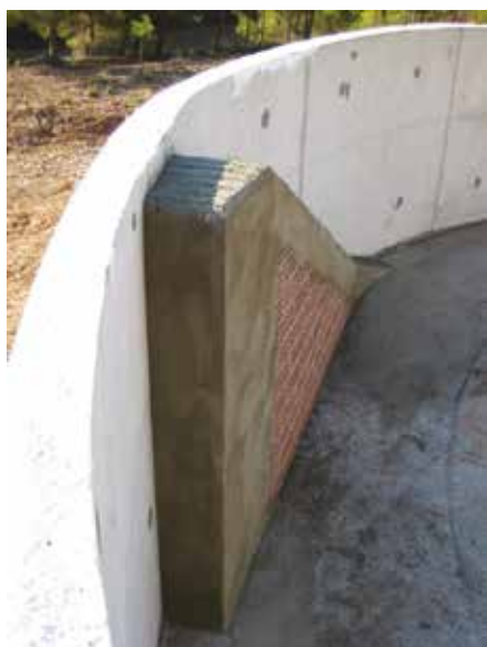
Εικόνα 6: Σταθερή διάταξη για δεξαμενές κάθετου τοιχώματος. Πηγή: Cap del Servei de Biodiversitat i Protecció dels Animals.
