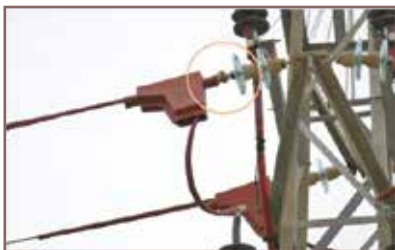
Εικόνα 11: Παραδείγματα καλυμμάτων τα οποία δεν τοποθετήθηκαν σωστά οδηγώντας σε μερική ή πλήρη έκθεση φορτισμένων μερών. α) Εκτεθειμένο μεταλλικό μέρος τερματισμών αγωγών ©Justo Martín. β) Κακή τοποθέτηση του καλύμματος (χιτώνιο) στον εναέριο αγωγό που οδήγησε σε αποκόλλησή ©Justo Martín. γ) Κακή τοποθέτηση του καλύμματος (χιτώνιο) στον εναέριο αγωγό που οδήγησε σε αποκόλληση και μετακίνησή του κατά μήκος του αγωγού ©James Dwyer (πηγή: Martín Martín et al., 2022).
