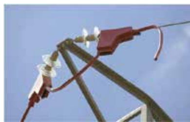
Εικόνα 11: Παραδείγματα καλυμμάτων τα οποία δεν τοποθετήθηκαν σωστά οδηγώντας σε μερική ή πλήρη έκθεση φορτισμένων μερών. α) Εκτεθειμένο μεταλλικό μέρος τερματισμών αγωγών ©Justo Martín. β) Κακή τοποθέτηση του καλύμματος (χιτώνιο) στον εναέριο αγωγό που οδήγησε σε αποκόλλησή ©Justo Martín. γ) Κακή τοποθέτηση του καλύμματος (χιτώνιο) στον εναέριο αγωγό που οδήγησε σε αποκόλληση και μετακίνησή του κατά μήκος του αγωγού ©James Dwyer (πηγή: Martín Martín et al., 2022).
