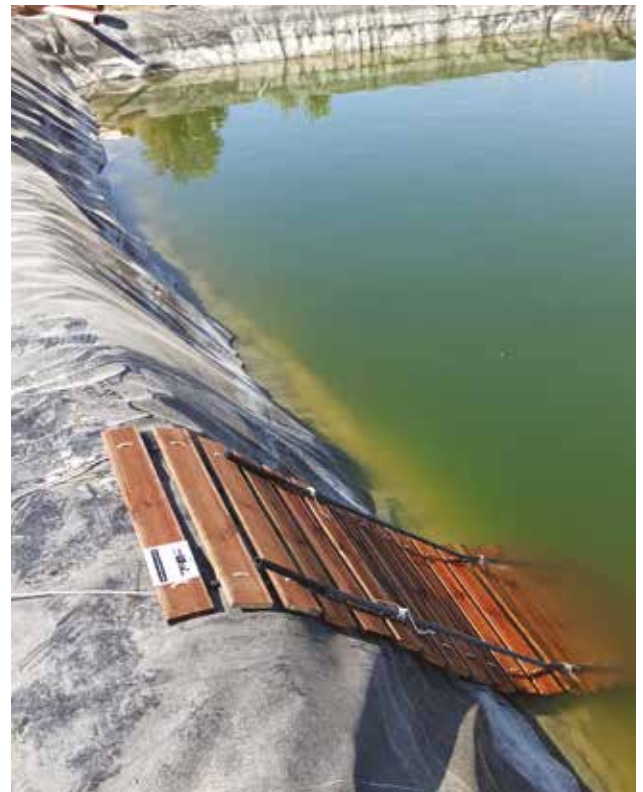
Εικόνα 14: Λανθασμένη τοποθέτηση σταθερής διάταξης διαφυγής. LIFE Bonelli eastMed©Αρχείο ΠΚ-ΜΦΙΚ.
