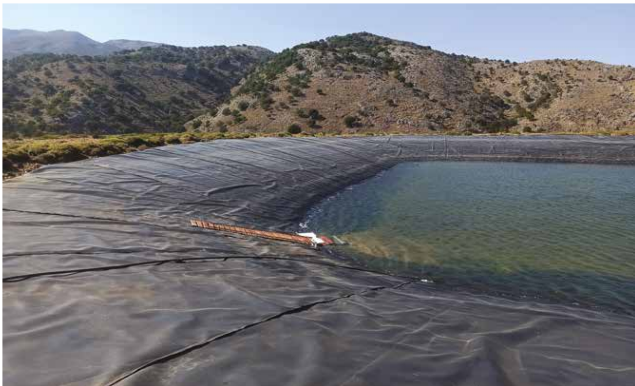
Εικόνα 9: Διάταξη αύξησης πρόσφυσης, σταθεροποιημένη σε δεξαμενή με κεκλιμένα τοιχώματα. LIFE Bonelli eastMed©Αρχείο ΠΚ-ΜΦΙΚ.
